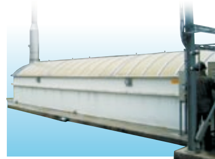
• Oczyszczalnia ścieków ze żłobem biologicznie zraszanym
