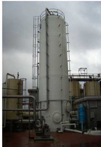
Schéma 24 : Unité de désulfuration biologique DMT à étage unique au sein une station d'épuration à Emek Hefer, Israël. Capacité de 1 500 m 3 / heure.
