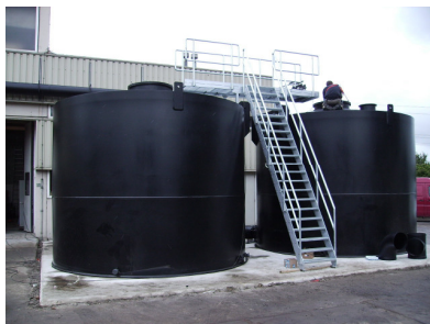
Schéma 21 : Unité de désodorisation biologique DMT à deux étages dans une station de pompage à Roosendaal, Hollande. Capacité de 3 600 m 3 / heure.
