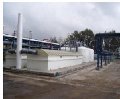
Schéma 20 : Unité de désodorisation biologique DMT à trois étages dans une station d'épuration industrielle à Haïfa, Israël. Capacité de 8 000 m 3 / heure
