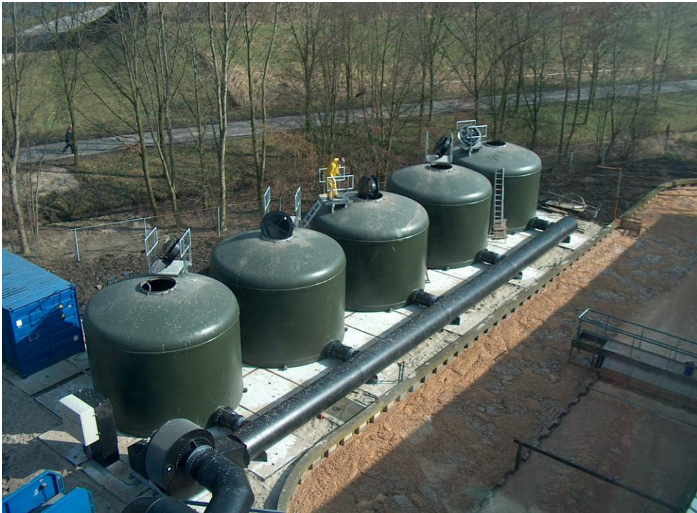
Installation de contrôle biologique des odeurs à un niveau DMT (35000 m 3 /heure) sur le site d'une usine d'épuration des eaux usées en Hollande.
