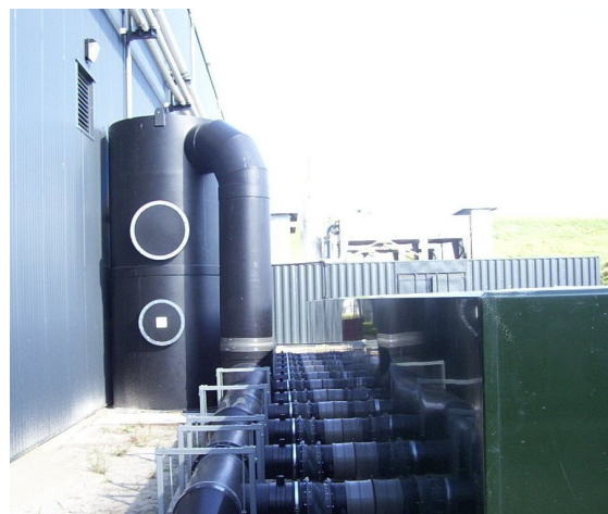
Figuur 8. Biofilter met voorgeschakelde luchtbevochtiger
