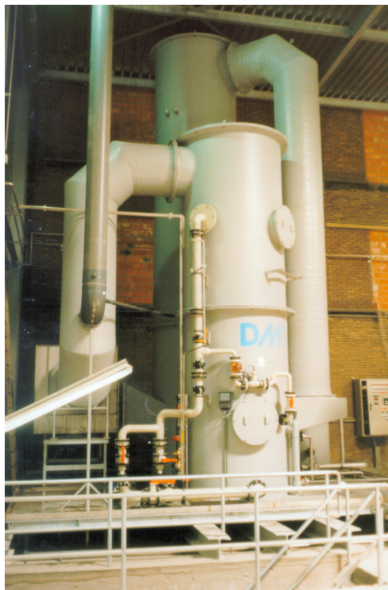
Figuur 7. Ammoniakstripper en -absorber
