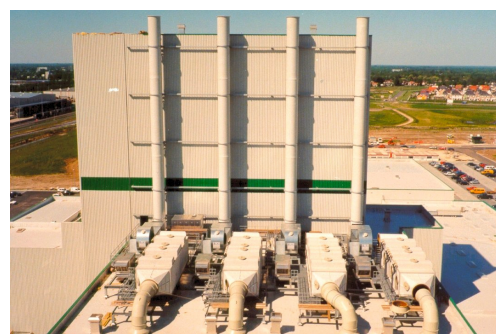
Figuur 3: meertraps kruisstroomwasser (4 units)
