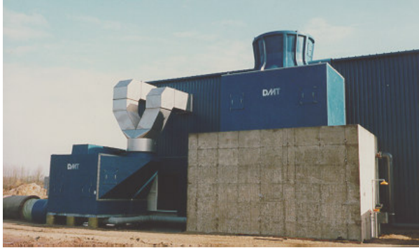
Ammoniak-absorber/koeler/condensor met koeltoren ter behandeling van dampen uit het composteringsproces voor chamignonmest 80.000m 3 /h
