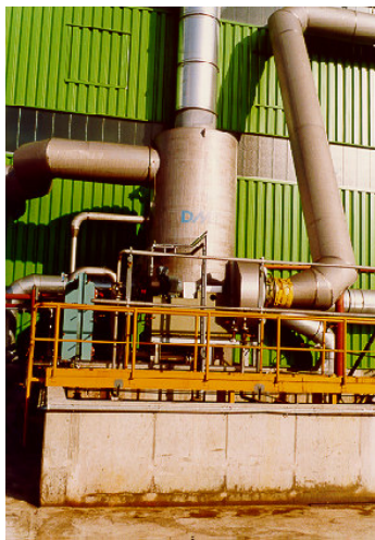
Natte stofvanger/koeler/condensor/absorber ten behoeve van soja bonen verwerking. 30.000m 3 /h
